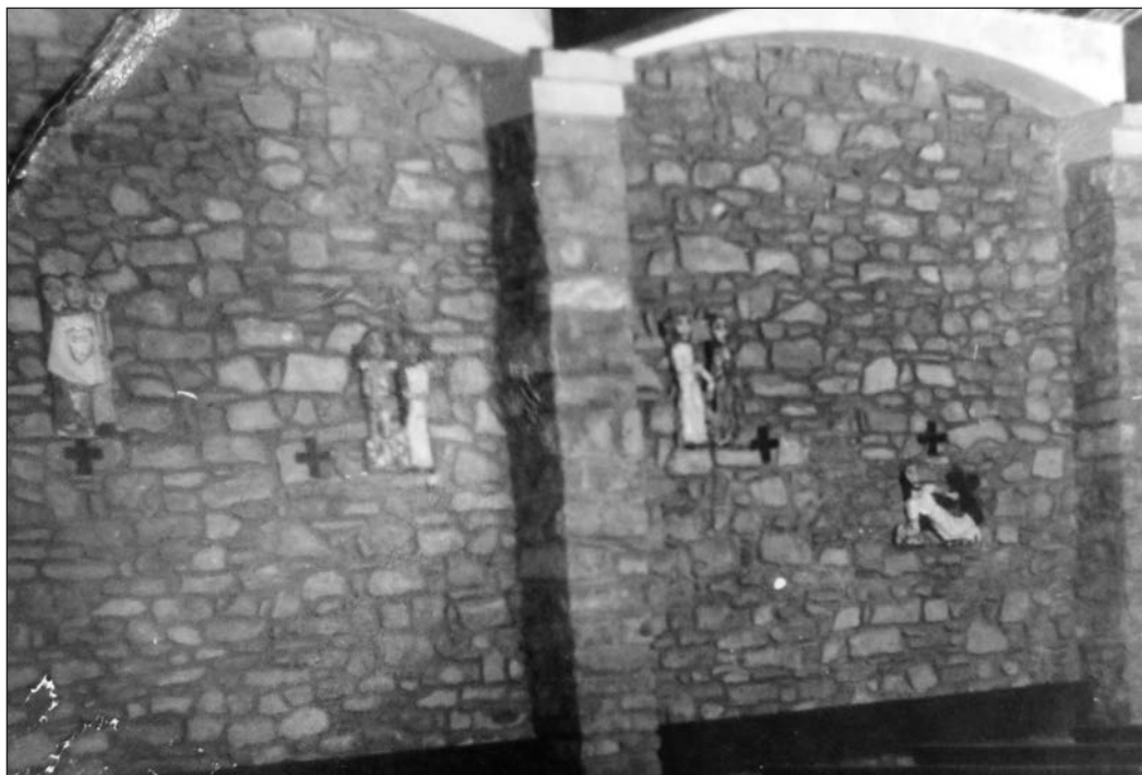
Interior de la capella del balneari.
